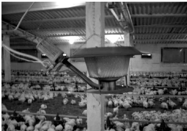
Fotografia 3.11 Radiantă de încălzire cu infraroșu
