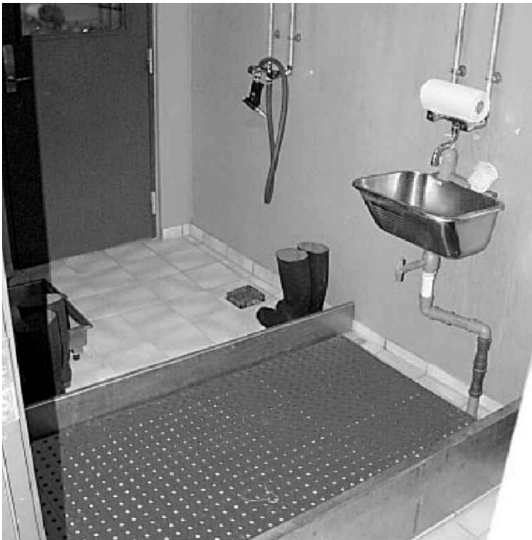
Fotografia 4.2 Accesul corect într-un adăpost pentru păsări necesită utilități corespunzătoare
