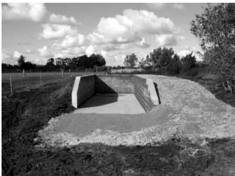
Fotografia 3.26 Platformă betonată cu pereți pentru depozitarea dejecțiilor
