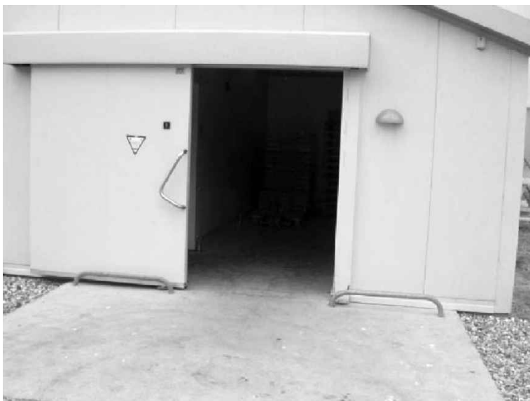
Fotografia 3.18 Este recomandat ca accesul în camera de depozitare a ouălelor să se poată face atât din exterior, cât și din interior
