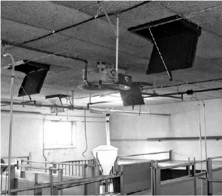
Figure 5.9 Adăpost cu sistem de difuzie a aerului
