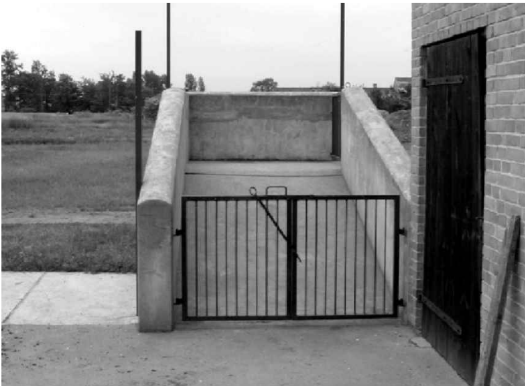
Figura 7.21 Rampa de încărcare
