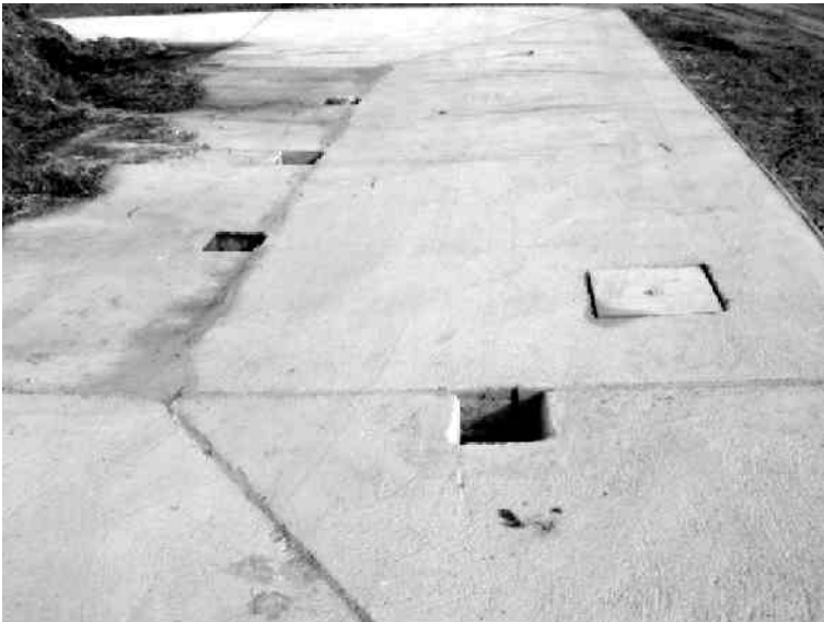
Figura 5.11. Exemplu de rezervor pentru purin îngropat cuplat cu o platformă de dejecții
