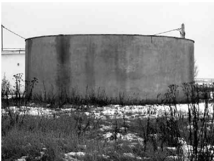
Figura 8.6 Rezervor circular de dejecții executat in situ
