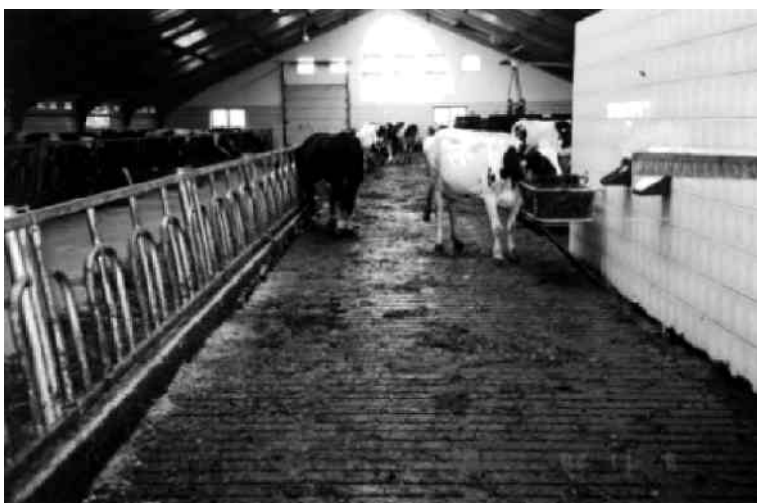
Figura 5.15. Stocarea dejecțiilor lichide într-un canal aflat de-a lungul aleii de furajare, sub pardoseala grătar
