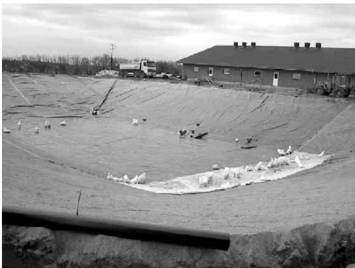
Figura 5.12. Batal pentru dejecții lichide aflat în construcție
