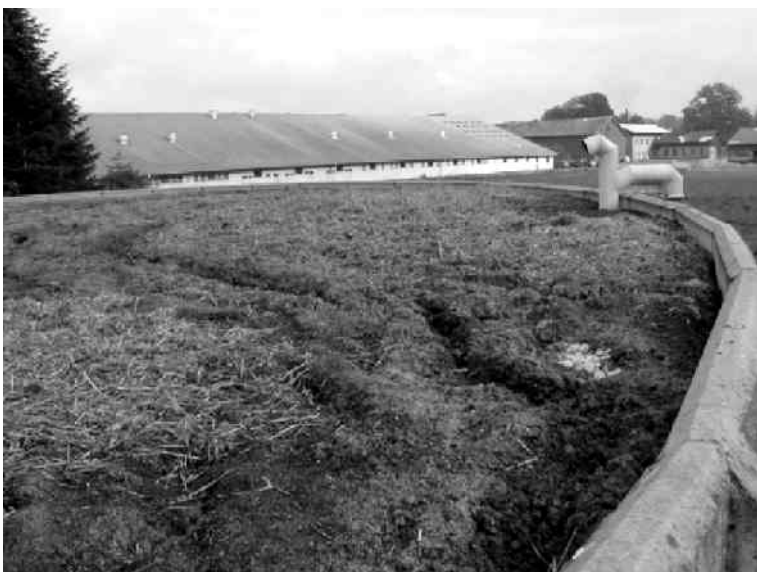
Figura 5.3. Strat plutitor din paie tocate
