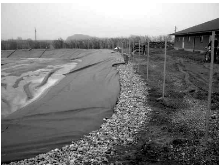
Figura 5.13 Batal pentru dejecții cu gard și unități de aerare
