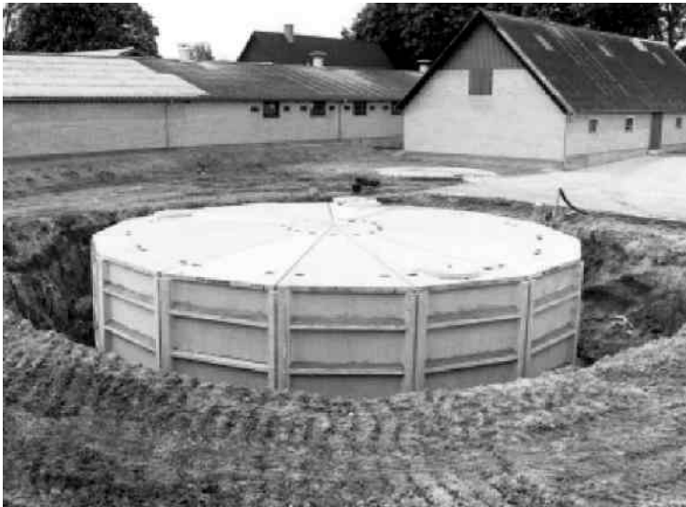
Figura 5.6. Planșeu din elemente prefabricate din beton
